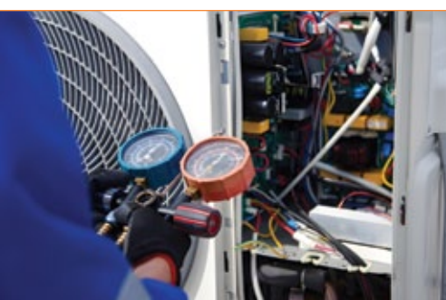
فحص الضغط لجهاز التكييف
