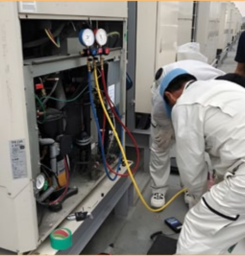
صيانة وحدة تكييف مركزي
