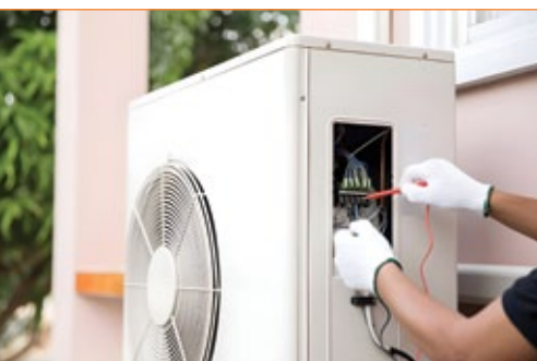
فحص التوصيلات الكهربائية لجهاز التكييف
