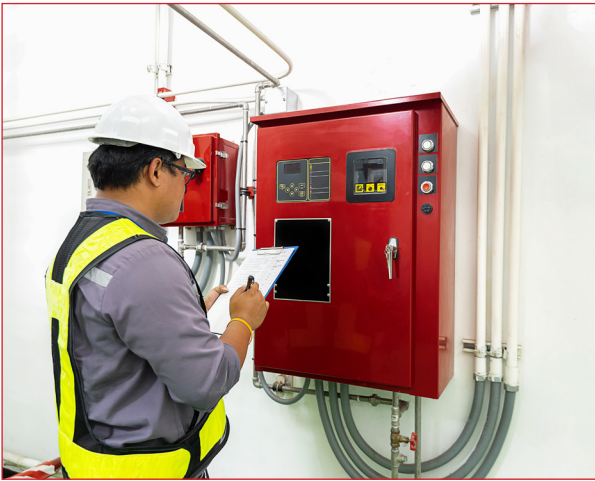
فحص وصيانة نظام إنذار الحريق
