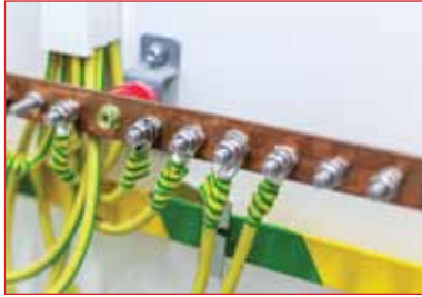
نموذج ربط الخط الأرضي للمعدات الكهربائية
