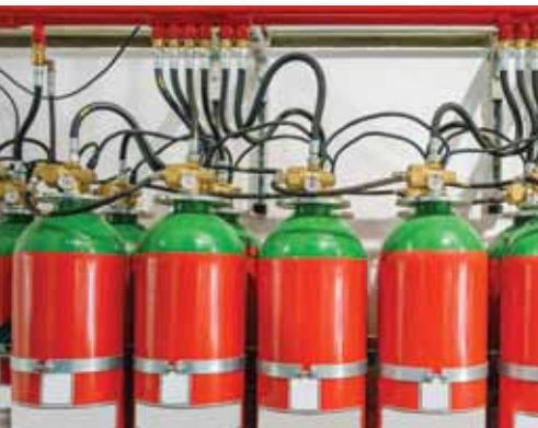
منظومة مكافحة الحريق باستخدام الغازات
