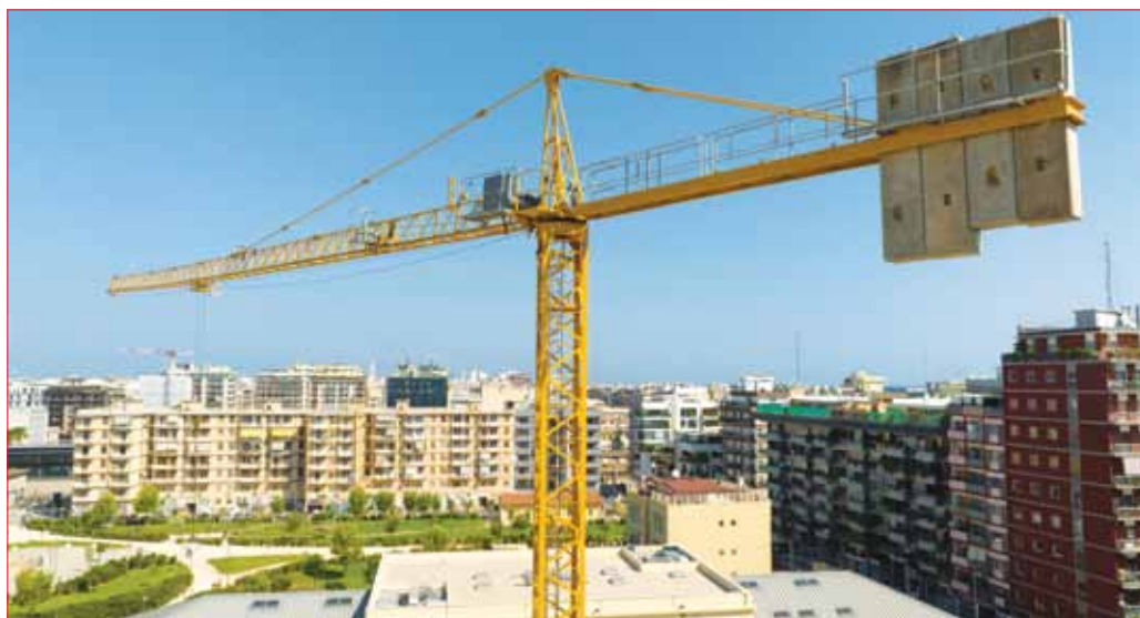
التوازن عامل أساسي لعمل الرافعات البرجية
